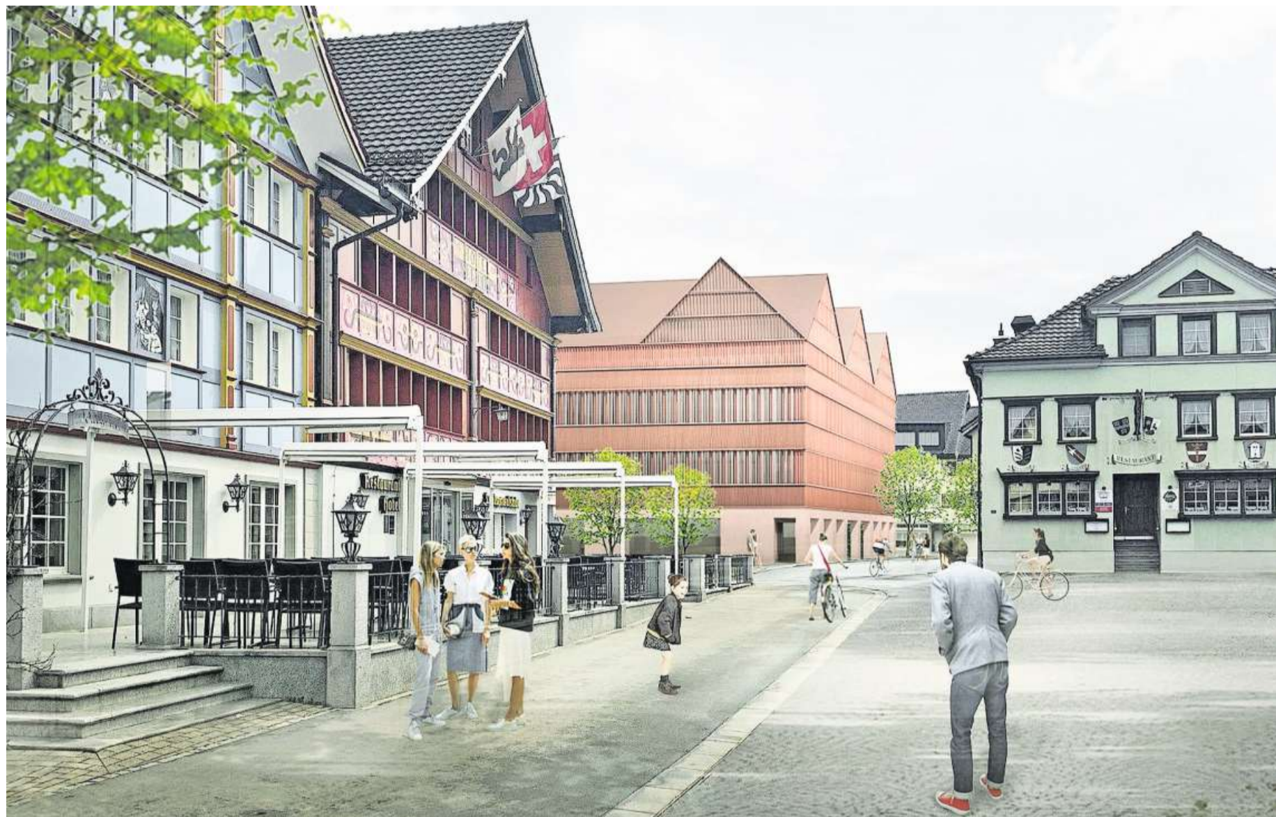
Es dürfte noch eine ganze Weile dauern, bis das neue Verwaltungsgebäude neben dem Landsgemeindeplatz steht.
